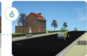
Stap 6 Aanleg wegdek
